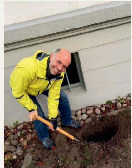
Tiefe Löcher graben, für neue Leitungen ins Pfarrhaus
