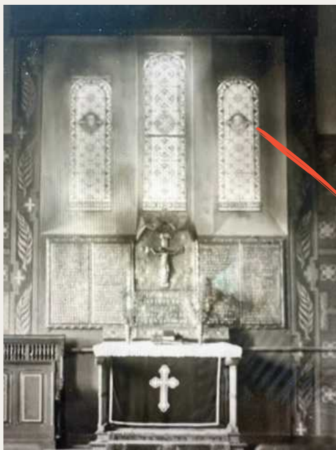
Die Fenster in der alten Altarwand. Luther – Blume – Melanchthon
